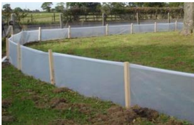
Figura nr. 6-30 Exemple de garduri temporare ce pot fi propuse pentru perioada de construcție
