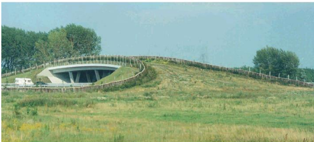
Figura nr. 6-24 Exemplu de pod verde construit în Ungaria (Iuell et al., 2003)
