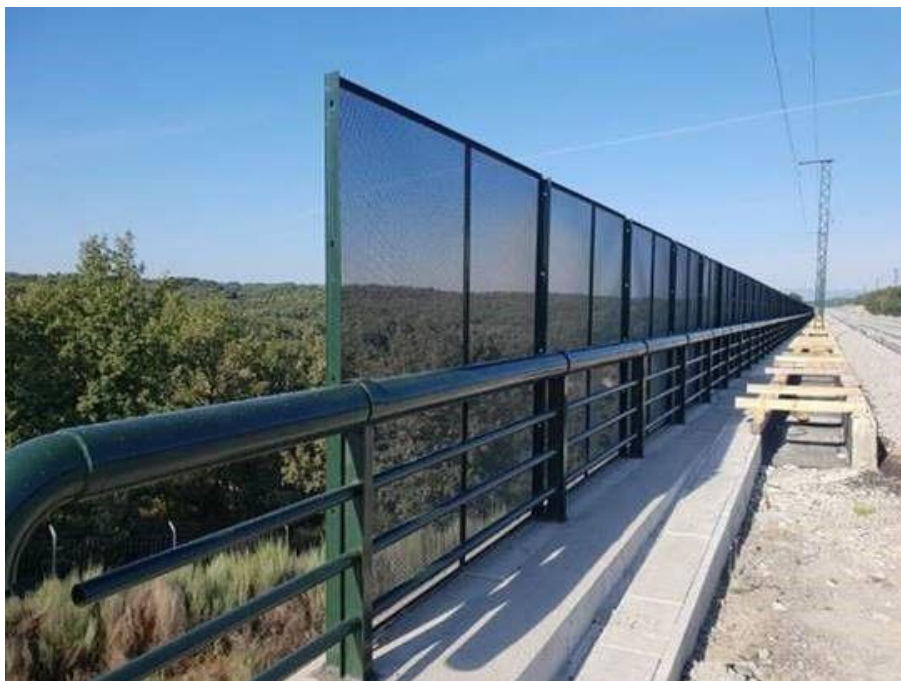
Figura nr. 6-29 Panouri anticolizune din plasă, amplasate marginal carosabilului unei viitoare autostrăzi
