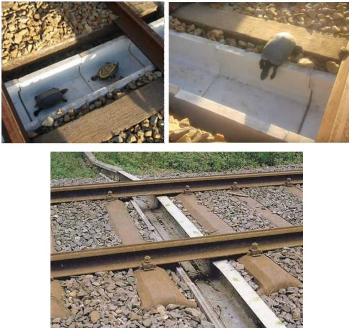
Figura nr. 6-27 Structuri de traversare pe sub șinele de cale ferată pentru speciile de faună de dimensiuni mici
