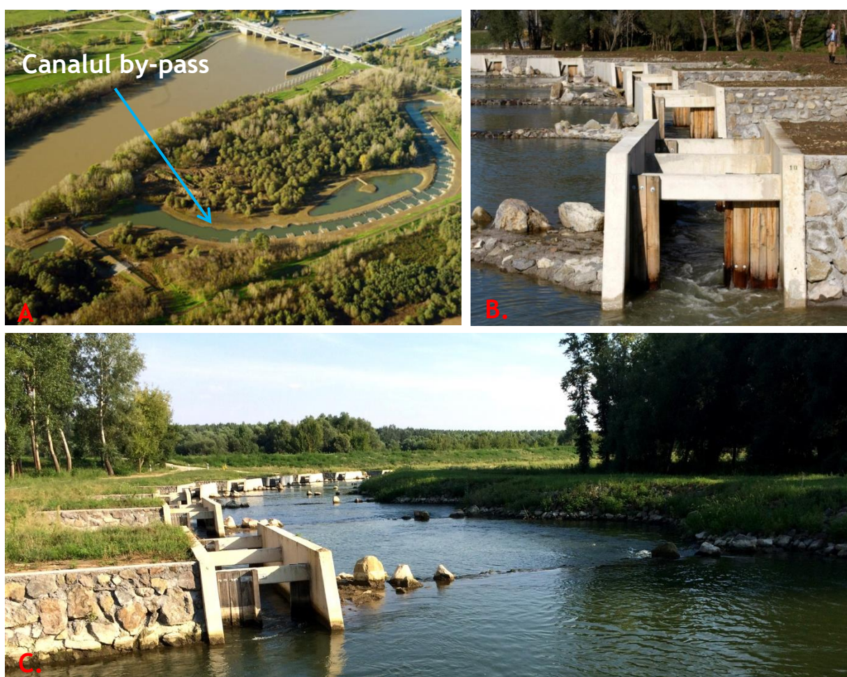
Figura 6-1 A. Canalul by-pass (vedere de ansamblu); B. Scara de pești cu structuri de trecere verticale; C. Vedere de ansamblu a zonei din amonte a scării de pești (sursa: Tünde, 2015)
