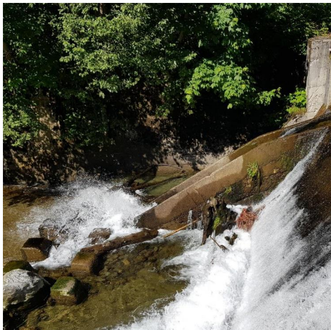
Figura nr. 6-18 Exemple de scări de pești din România proiectate și executate incorect și care sunt imposibil de trecut pentru speciile bentonice de pești
