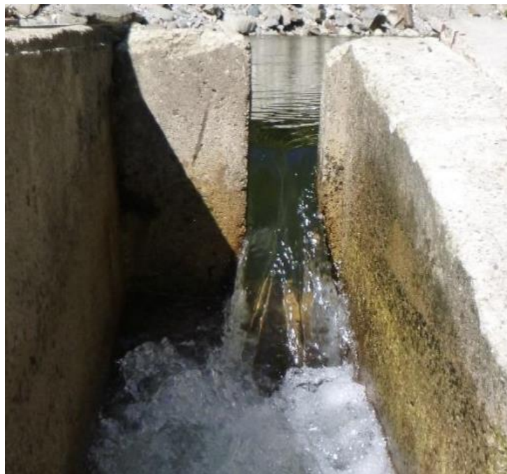
Figura nr. 6-18 Exemple de scări de pești din România proiectate și executate incorect și care sunt imposibil de trecut pentru speciile bentonice de pești
