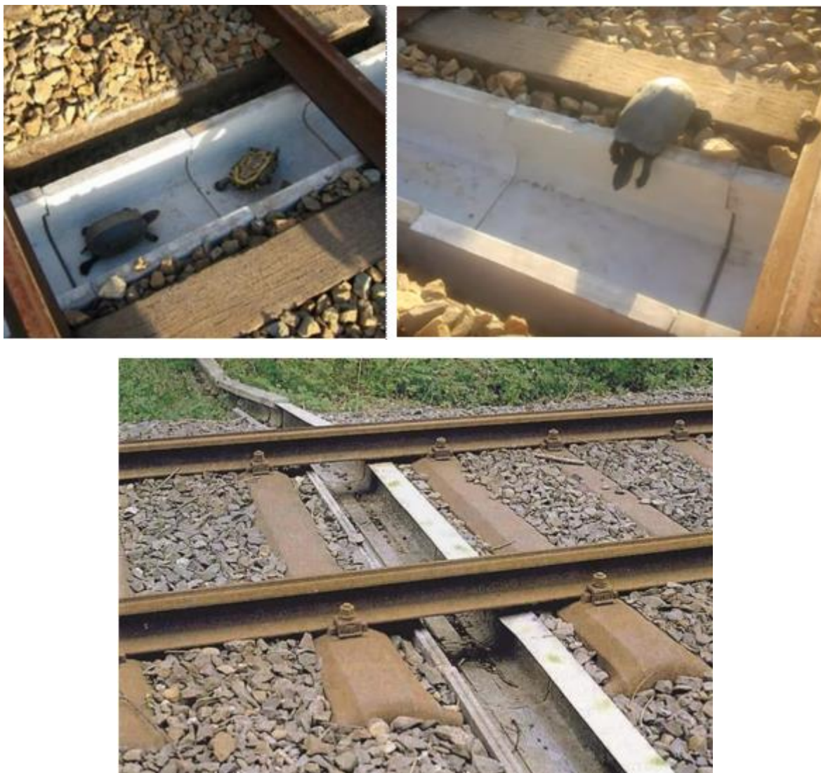
Figura nr. 6-33 Structuri de traversare pe sub șinele de cale ferată pentru speciile de faună de dimensiuni mici
