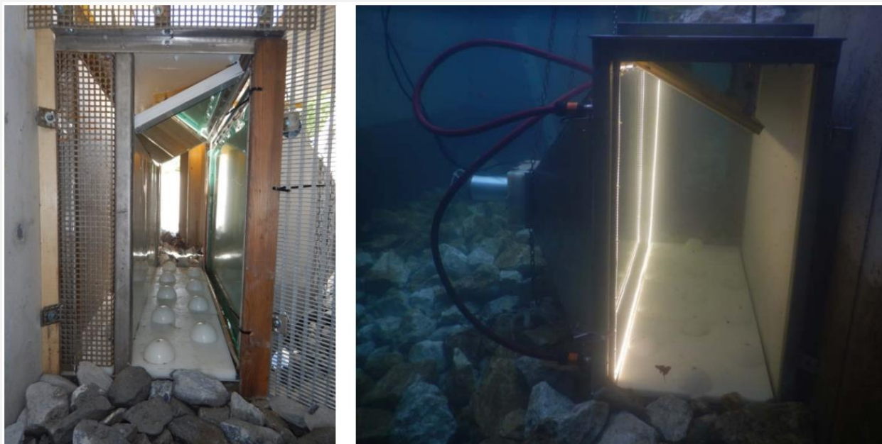
Figura nr. 6-59 Sistemul de monitorizare video realizat de VERBUND pe râul Drava
