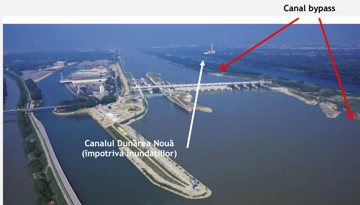
Figura nr. 6-54 Zona hidrocentralei Freudenau, împreună cu canalul Dunărea Nouă și canalul bypass (BOKU, 2015 16 )
