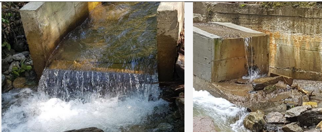
Figura nr. 6-6 Exemple de scări de pești observate în timpul investigațiilor în teren realizate pentru proiect
