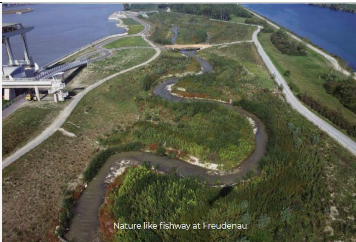
Figura nr. 6-55 Vedere detaliată a canalului bypass de la hidrocentrăla Freudenu (FITHydro, 2021 17 )
