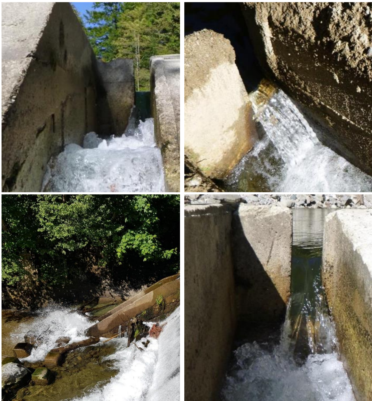
Figura nr. 6-50 Exemple de scări de pești din România proiectate și executate incorect și care sunt imposibil de trecut pentru speciile bentonice de pești
