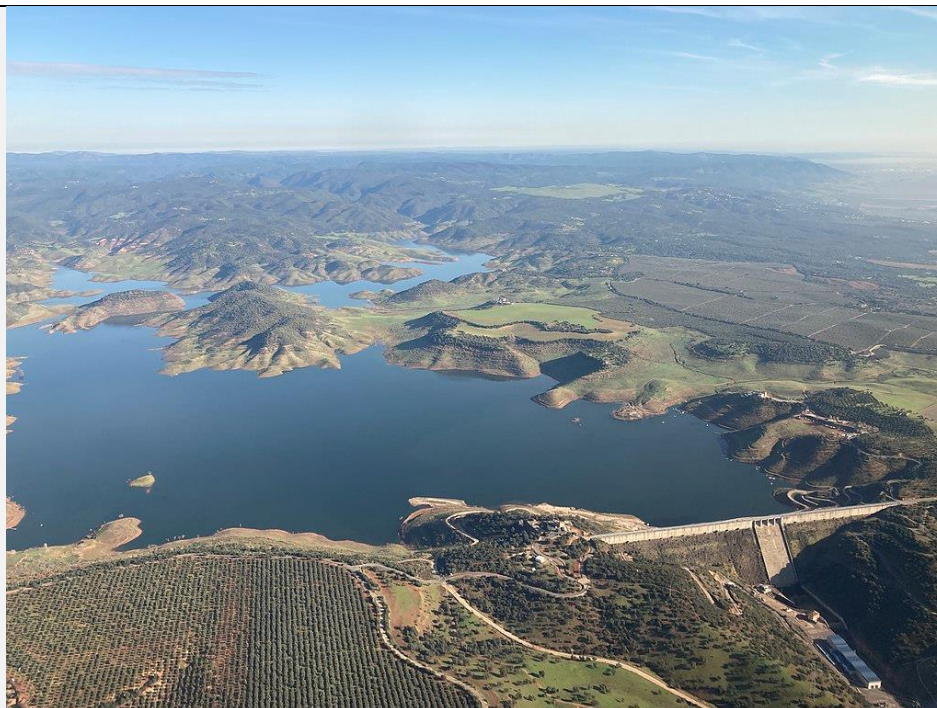
Figura nr. 6-70 Barajul Breña II
